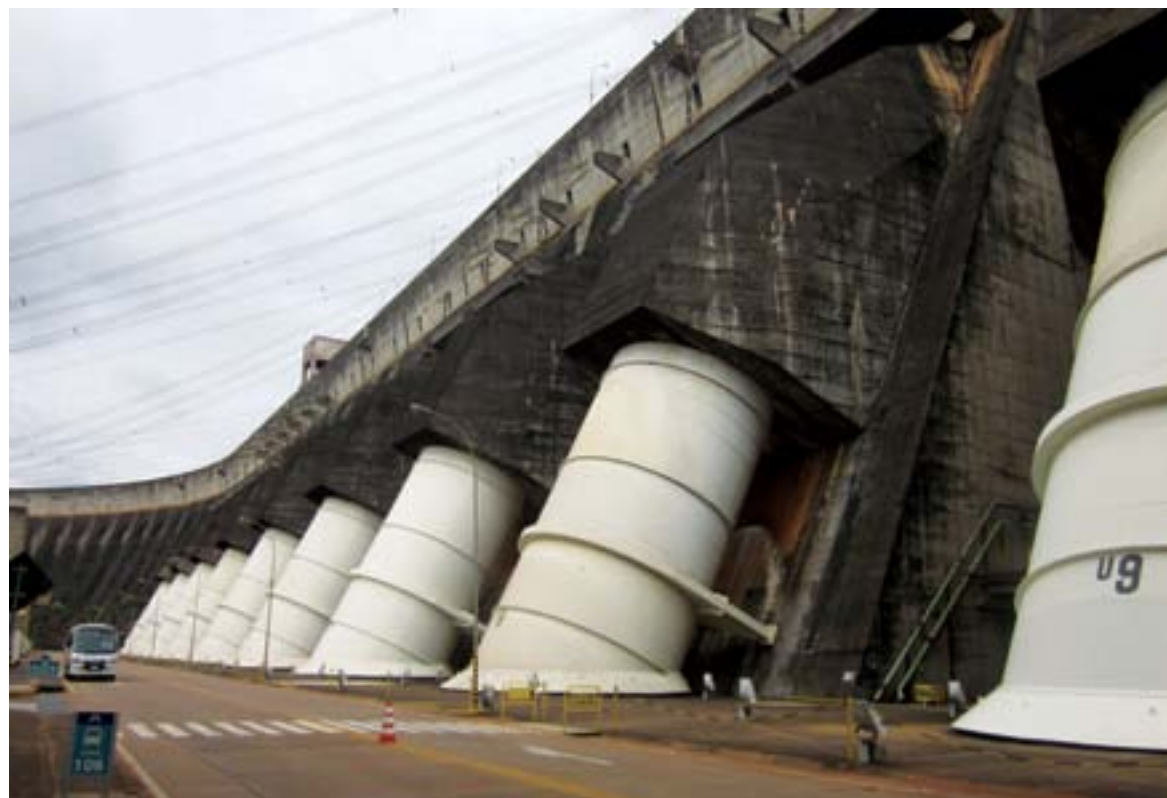
► Pieni osa kahdestakymmenestä vesiputkesta
