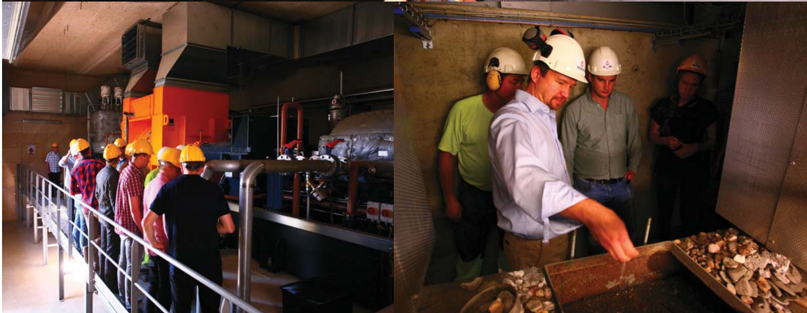
> Kuvia laitoksen sisältä: biomassasiilo, kurkistusaukko kattilaan, turbiini ja generaattori sekä Janne Kerttula esittelemässä kattilalaitoksen laitteistoja.
